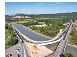
Sur l'A51, les nouveaux aménagements de l'échangeur de Cadarache (Bouches-du-Rhône), qui dessert notamment le pôle de recherche du CEA, ont été mis en service durant l'été 2024.
