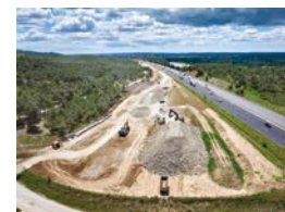
Sur l'A7, les travaux de création des demi-échangeurs de Salon nord (Bouches-du-Rhône) et Vienne sud (Isère) ont débuté à l'automne 2024, pour être achevés respectivement début 2026 et fin 2025.
