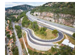
Sur l'A8, trois opérations achevées en 2024 : la nouvelle bretelle de sortie de Monaco, le réaménagement du diffuseur de Mougins et celui de la bretelle d'entrée de Menton (Alpes-Maritimes).
