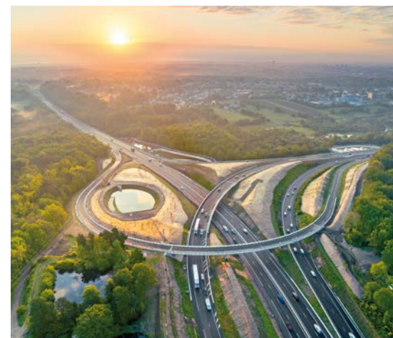
Sur l'A11, l'aménagement de la porte de Gesvres, à la jonction avec le boulevard périphérique de Nantes (Loire-Atlantique), inauguré en juin 2024, a porté à 2x2 voies des liaisons entre les périphériques nord et est, et créé une voie supplémentaire dans chaque sens entre les portes de Rennes et de la Chapelle.
