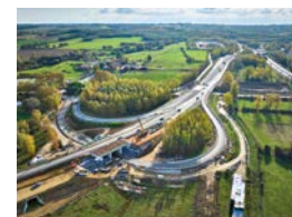
Sur la bretelle autoroutière A680, l'élargissement sur 7,6 kilomètres d'une route existante et la création de l'échangeur de Verfeil, à la jonction avec la future A69 à proximité de Toulouse (Haute-Garonne), sont en cours.
